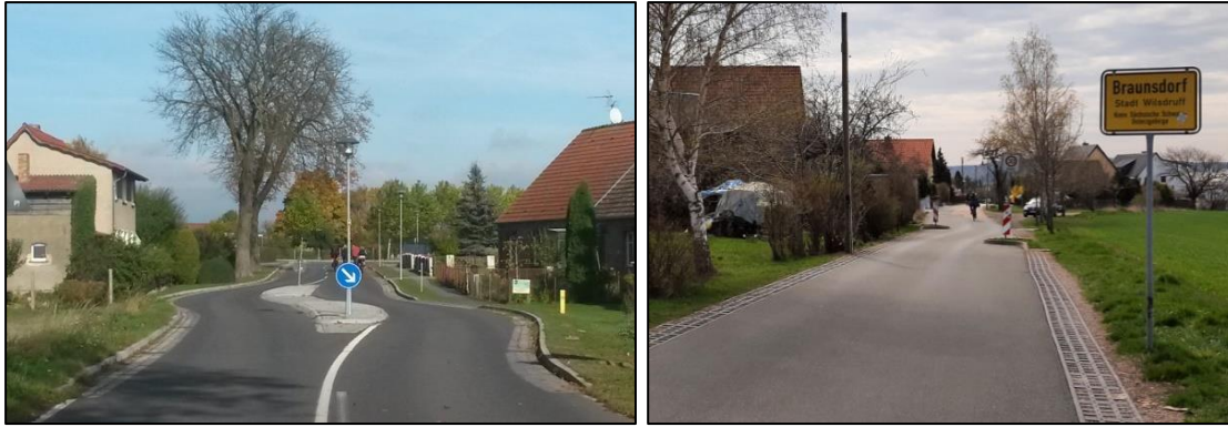
Abb. 15 Beispiele Ortseingangsgestaltung mit Fahrstreifenversatz
