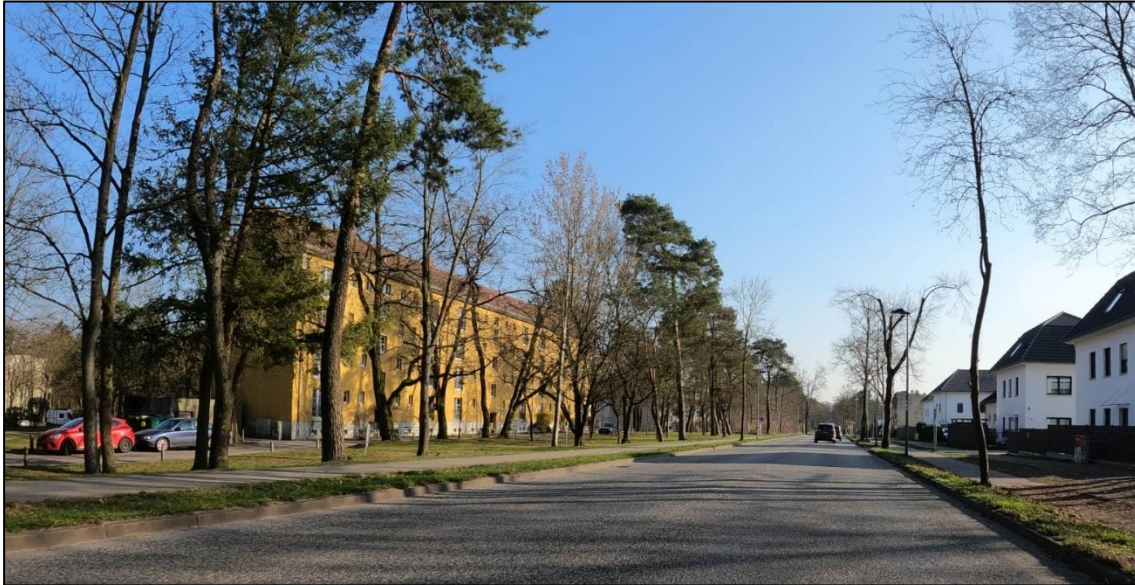
Abb. 17 Bestandssituation Berliner Allee
