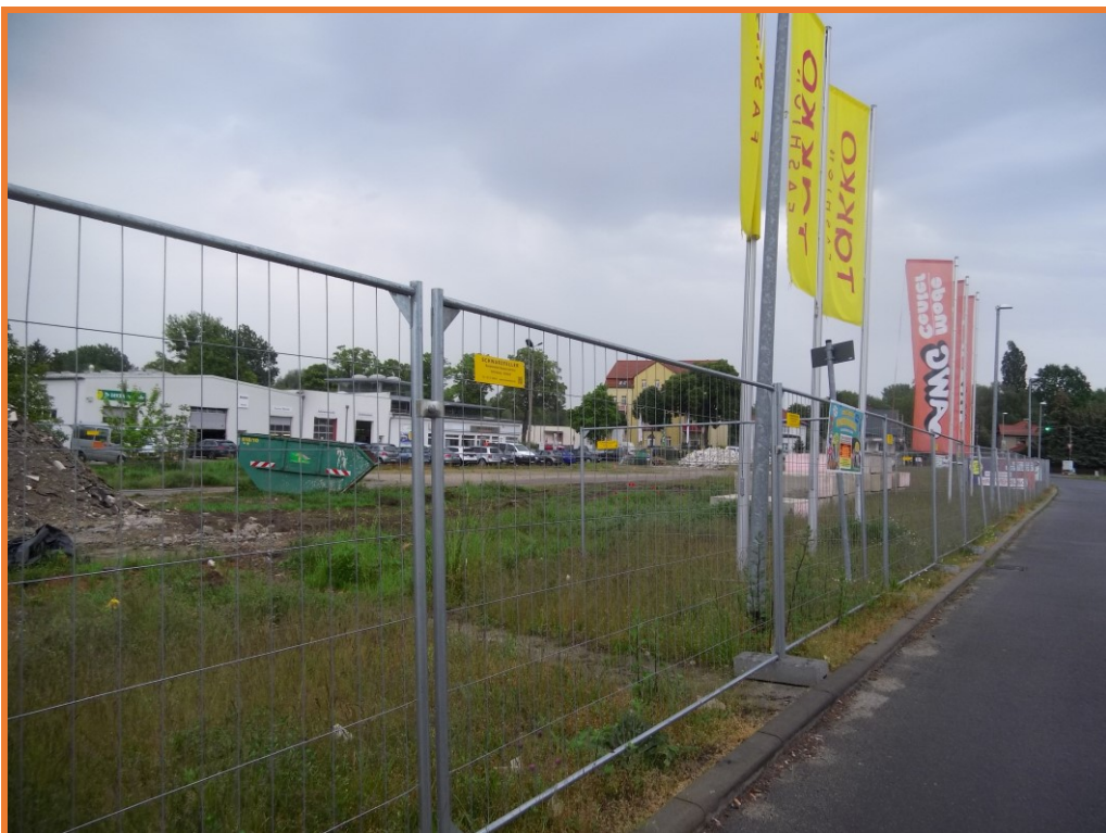
Abb. 1d: Baustelleneinrichtung im N-Teil des Plangebietes
