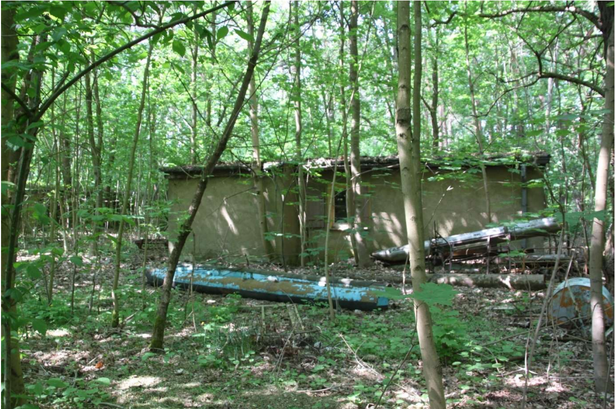
Abbildung 5 fast verfallener Bungalow und diverse Müllablagerungen
