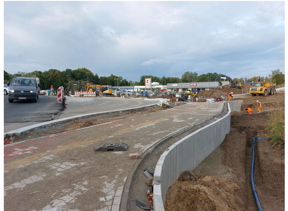
Kreisverkehr B96, Gehweg Richtung SÜ
