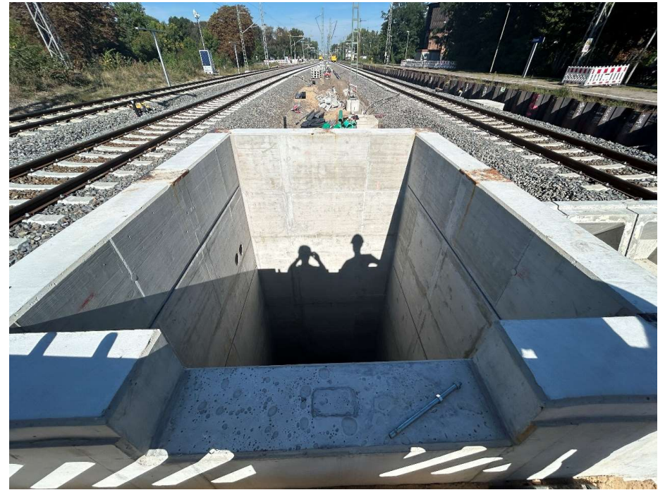
Bahnhof Zossen, Aufzugschacht
