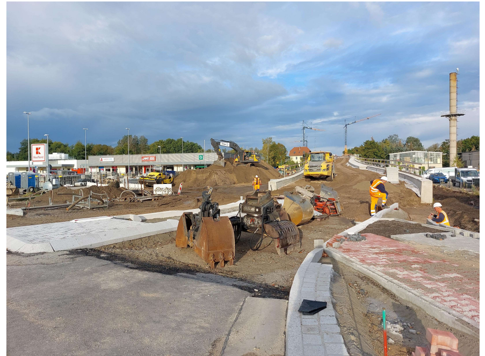
Kreisverkehr B96, Richtung Straßenüberführung
