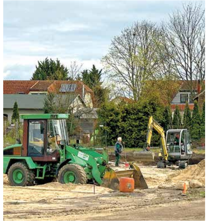
Die Bauarbeiten für die Kita in Nächst-Neuendorf haben begonnen.
