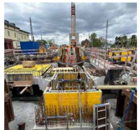
Hier entsteht ein Tunnelsegment am Bahnhof Zossen.
