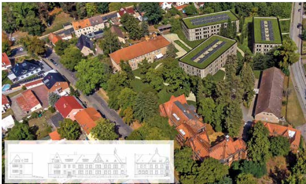
Luftbild vom Gelände des alten Krankenhauses am Weinberg. Im Hintergrund ist das Gelände der Lebensstadt.
