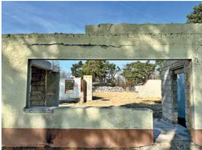
Die alten Mauern der Bowlingbahn konnten stehen bleiben.
