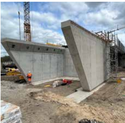
Hier entsteht die neue Brücke über die B246
